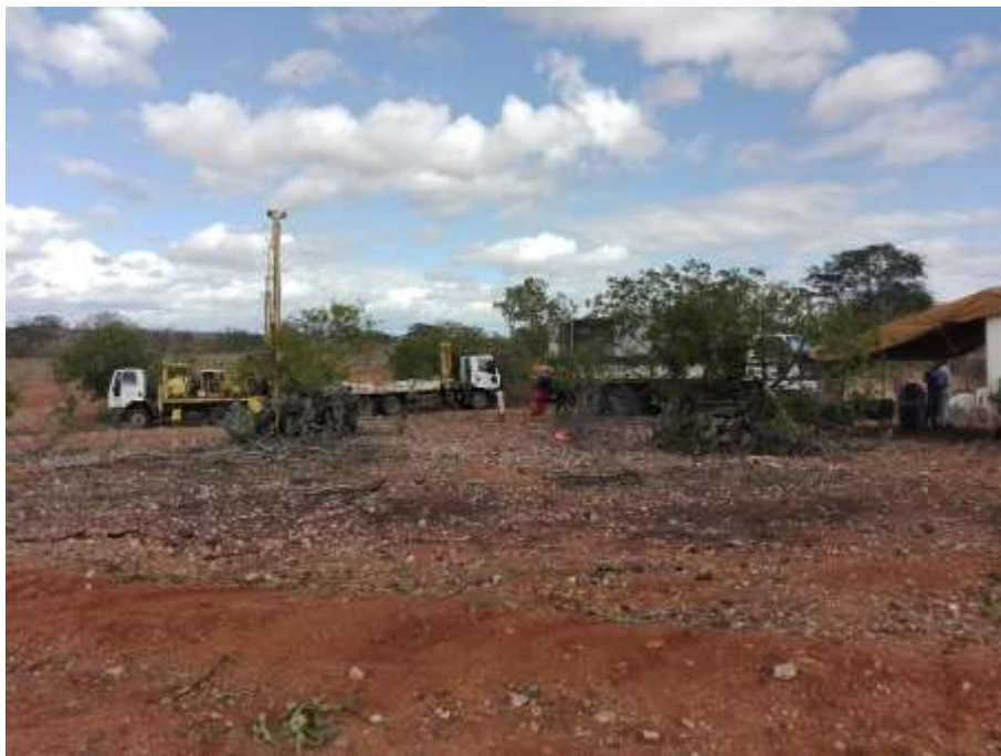
Foto 17: Perforación de pozo, comunidade Monte Alegre
